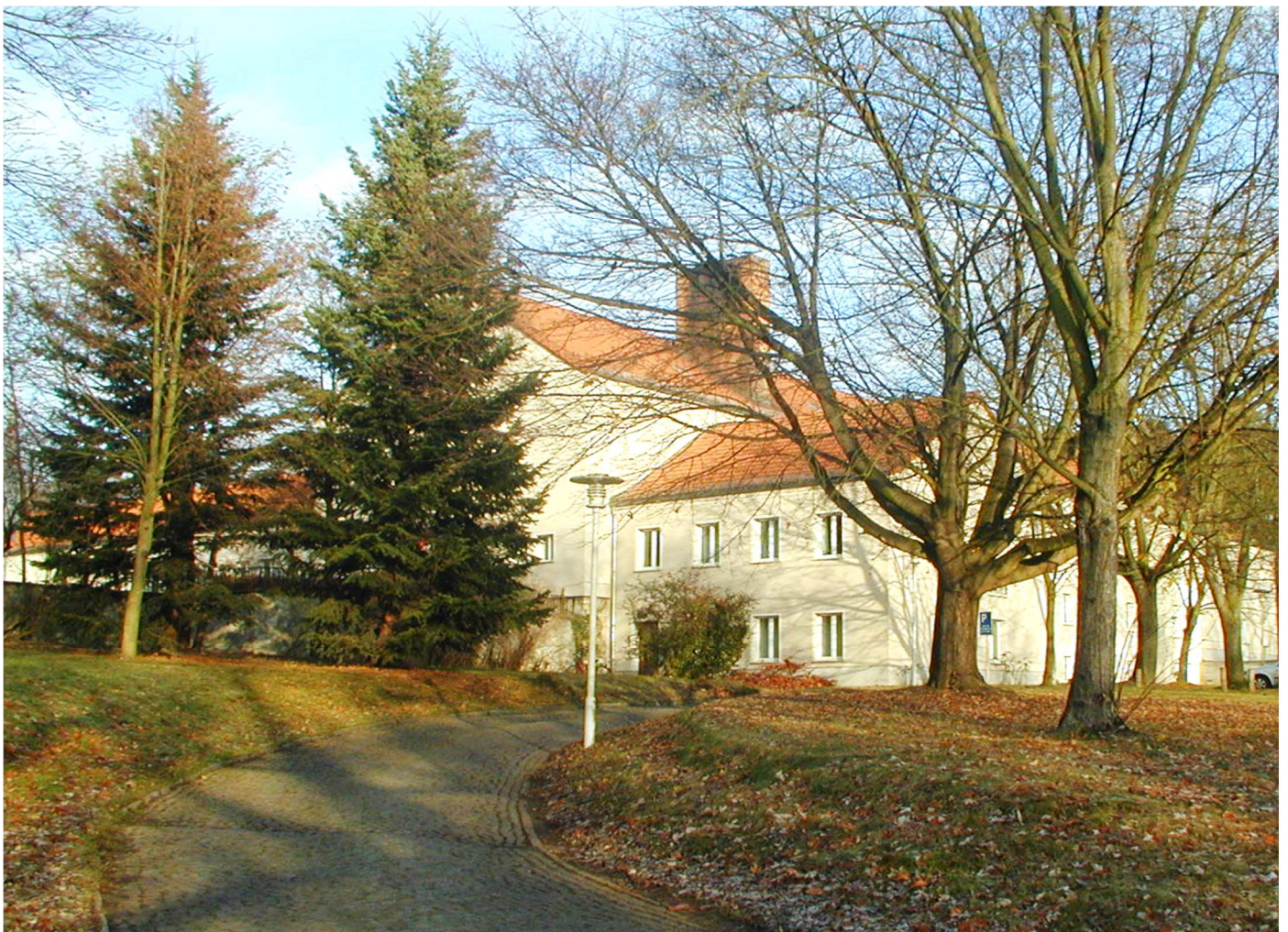
Zufahrt zur seitlichen Einliegerwohnung der BSFuDP
