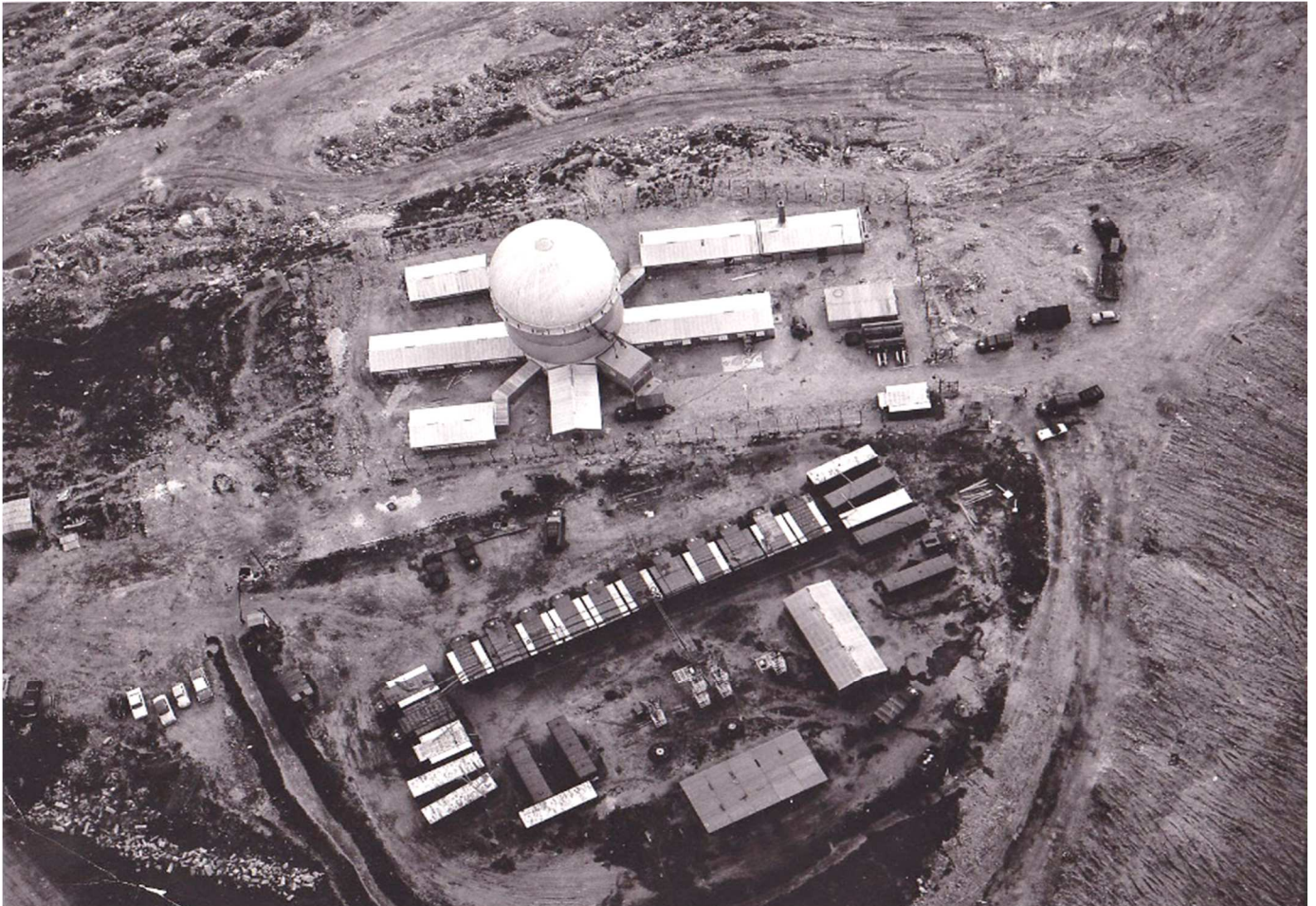
Baumaßnahmen im laufenden Luftraumüberwachungs-Betrieb auf dem Teufelsberg zur Erweiterung der stationären Luftraumüberwachung und dem Aufbau einer zentralen Funkmeßstation in den 1950er Jahren, Quelle: US Army Intelligence und Security Command
