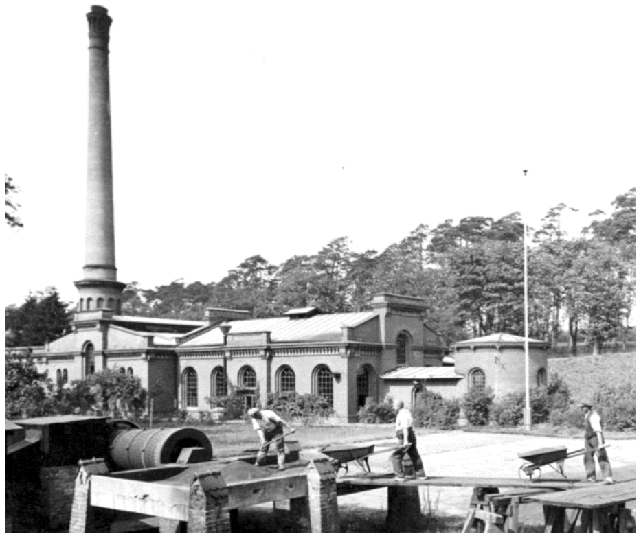
Wasserwerk Teufelssee, Quelle: Naturschutzzentrum Ökowerk Berlin e.V
