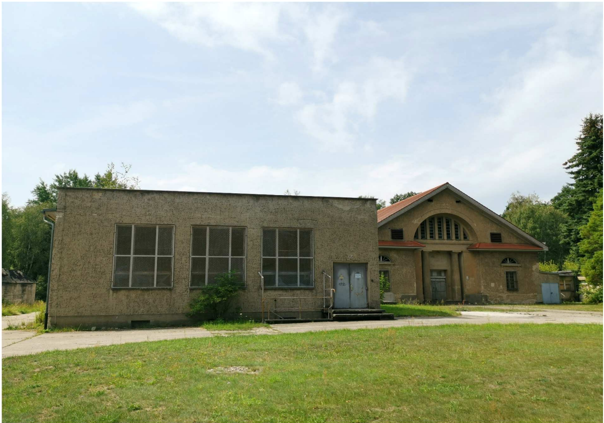
Der seitliche Anbau am Sendehaus 2 in welchem sich die Senderhalbzüge vom 2 x 50 KW Kurzwellensender 24, die Energieeinspeisung und die sechs Modulationstransformatoren für die Sender 22, 23 und 24 befanden. Auf der rechten Seite vom Anbaubauwerk befindet sich die Metalltür zur Energieeinspeisung. Bildquelle: ZThomas
