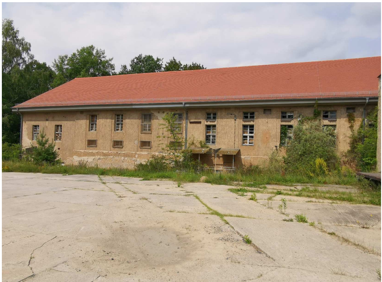
Der linke Seitenbereich vom Sendehaus 2 mit mittig befindlichem Kellerzugang zur Teilunterkellerung. Im Kellerbereich befand sich die Destillationsanlage zur Erzeugung destillierten Wassers für das Kühlsystem aller Sender mit dazugehörigen Pumpen- und Steuerungsanlagen. Bildquelle: ZThomas Wikimedia
