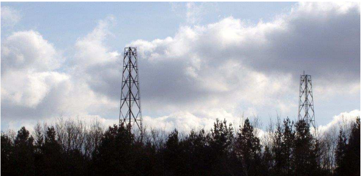
Die Stahlgittermasten am Rande des Sendegeländes vom Großrundfunksender Tegel. Die Aufnahme entstand im Jahre 2020. Bildquelle: Gerhard Völzmann (Geschichtsforum Tegel – Tegelportal)
