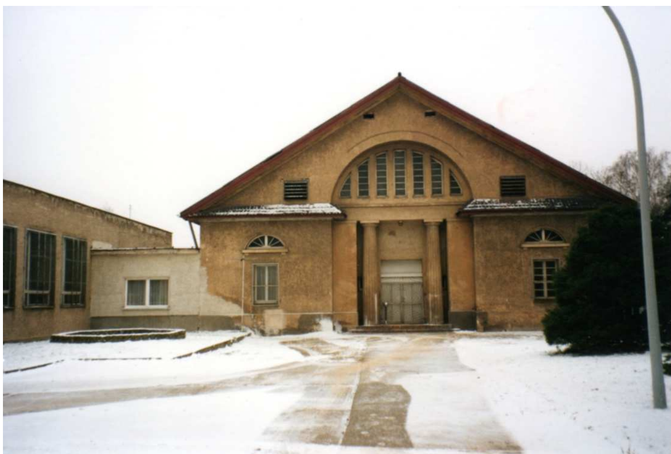
Das Sendehaus 2 auf dem winterlichen Funkerberg in Königs Wusterhausen. Der Haupteingang zwischen den Steinsäulen ist von außen durch eine Gittertür geschützt und war immer verschlossen, sodaß der Personaleingang durch den Anbau auf der rechten Seite genutzt wurde.
