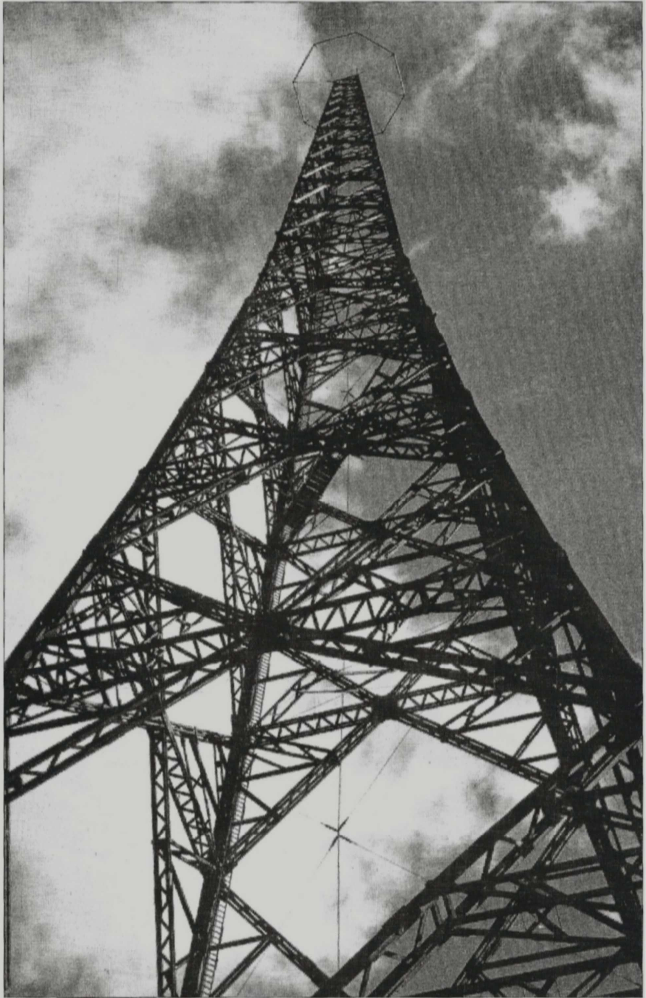
Der hölzerne Hauptsendemast des Großrundfunksender Tegel im Jahre 1940. Bildquelle: Geschichtsforum Tegel - Tegelportal
