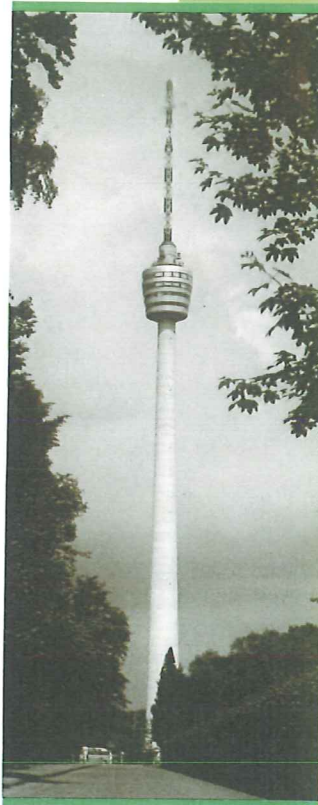
Erster „Antennenträger“ aus Beton, SDR 1956
