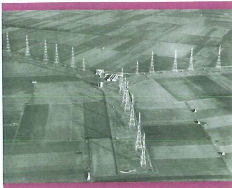
KW-Sendeanlage der Deutschen Welle in Jülich
