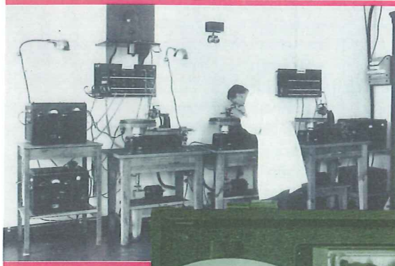
Schallplatten- aufnahme mit Wachsschneide- maschine, 1931
