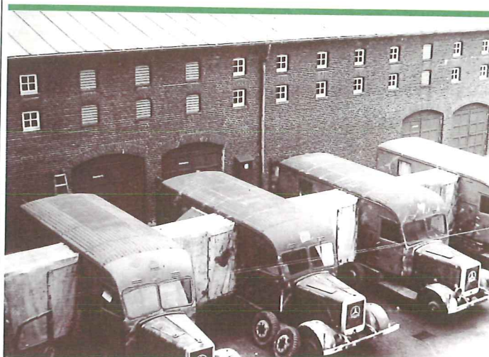
Provisorische, fahrbare Sendeanlage des NWDR in Osterloog, 1945
