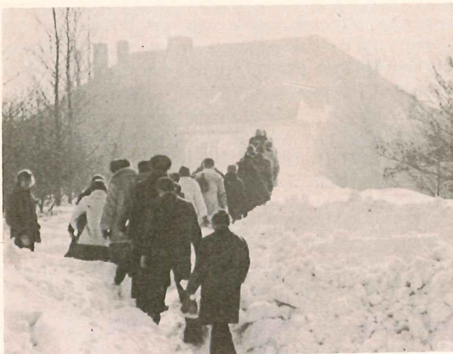
Bild 41: Erste Ablösung auf der Empfangsfunkstelle Utlandshörn am 20. 2. 1982; Foto: DBP
