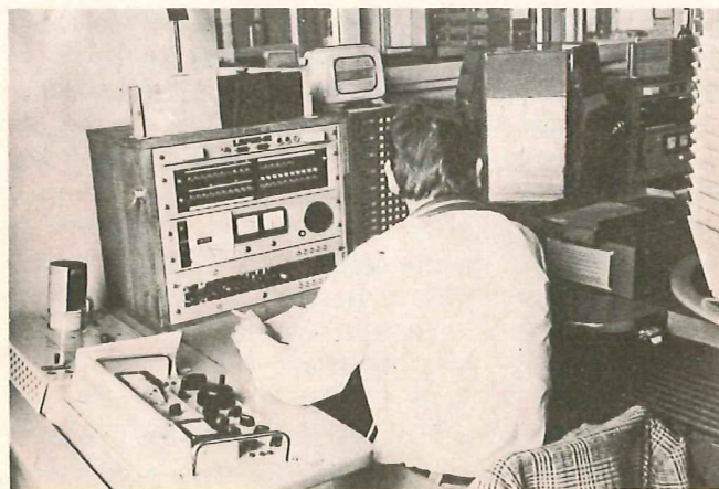
Bild 36: Empfangsfunkstelle Utlandshörn, Arbeitsplatz für den Sprechseefunkdienst auf Kurzwellen mit Empfänger EK 07 und Einseitenbandauswahlgerät NZ 10, 1961; Foto: DBP
