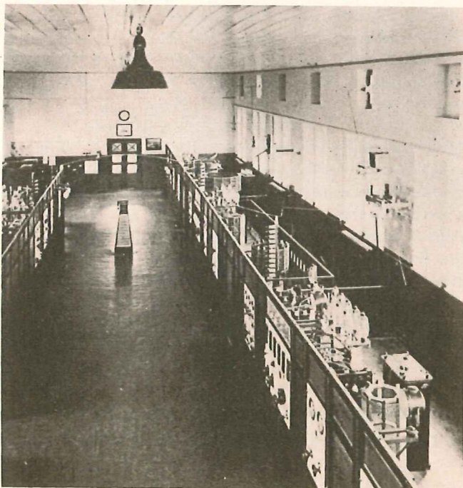
Bild 16: Sendefunkstelle Norddeich, 1929, 10-kW-Kurzwellensender, 20-kW-Longwellensender und 5-kW-Grenzwellensender; Foto: DBP
